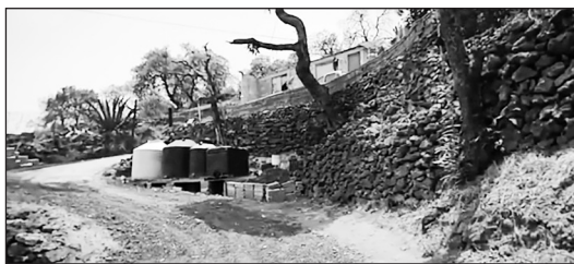
Captador de agua de lluvia, Delegación Tlalpan
